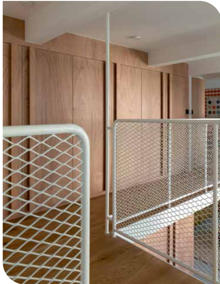
----- Kasten maatwerk in okoumé multiplex. -----
